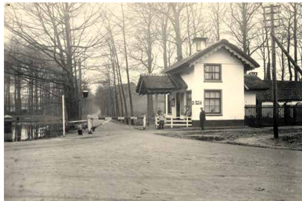
Het Veenhuizer tolhuis, kijkend in de richting van De Bilt. Voor de tol links de Veenhuizerweg (verhard), rechts de Hessenweg (onverhard). Datering 1924-1928 (HUA, cat.nr. 220771).
