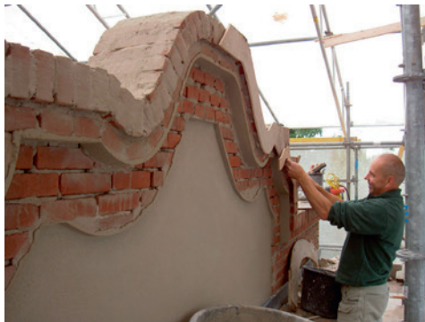
Restauratie metselwerk Villa Veltheim
